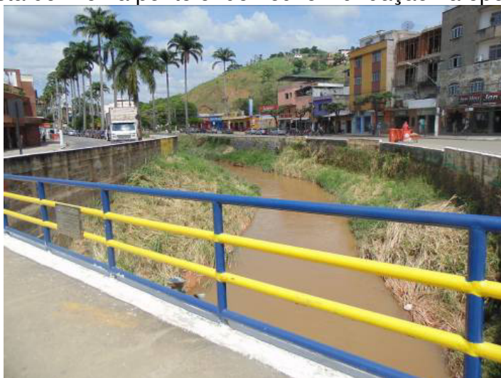
Vista do Rio na ponte onde houve inundação na época.
