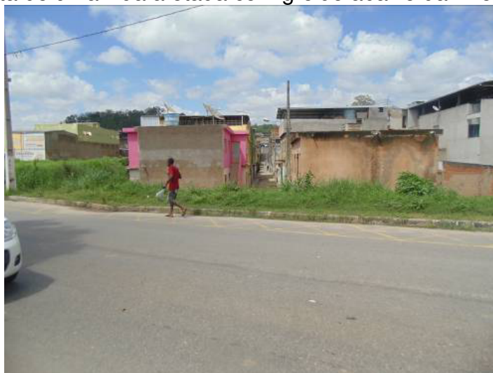
Vista de uma Rua afetada com greide abaixo da Avenida
