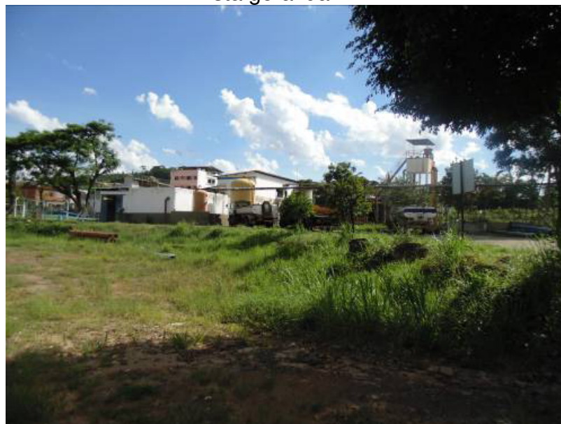
Vista geral da ETA
