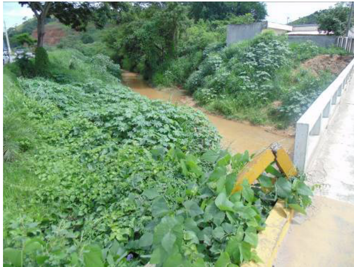
Ponte sobre a Avenida e o Rio.
