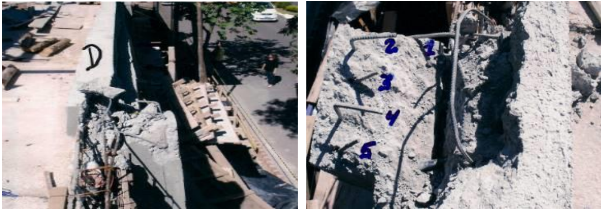
Vistas da Marquise Sinistrada – Armaduras e Ancoragem
