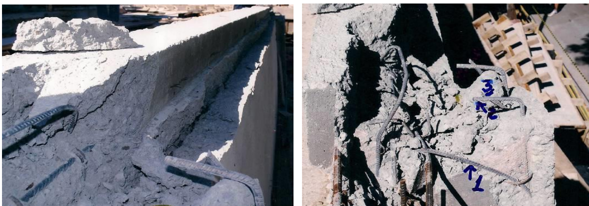
Vistas da falta de armadura negativa e da ancoragem insuficiente da viga lateral
