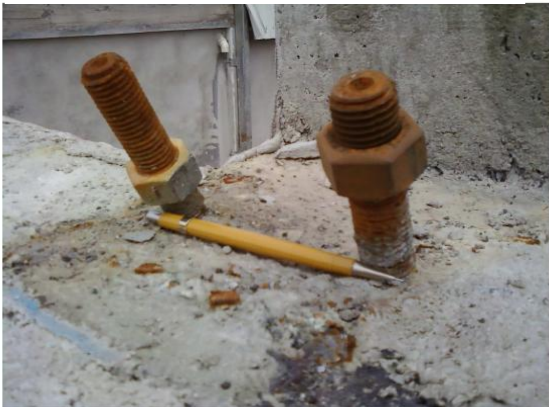
Figura 32 - Novamente se nota que a porca está afastada da base e sem arruela
