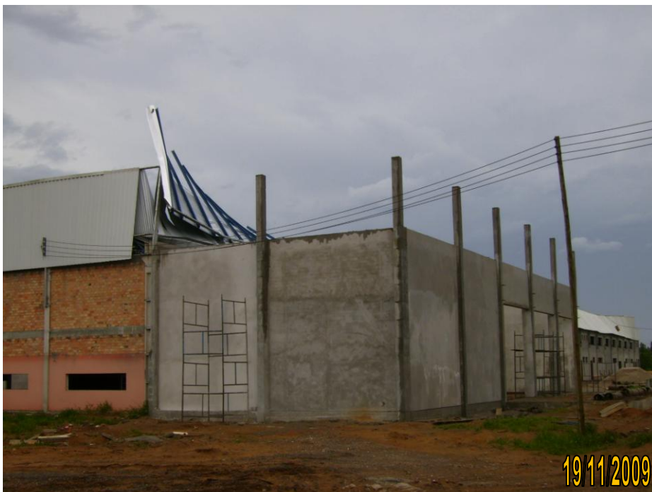
Figura 5 - Em 19/11/2009, o vento forte arrancou a estrutura metálica do telhado do deck, com área de 245,41 m 2
