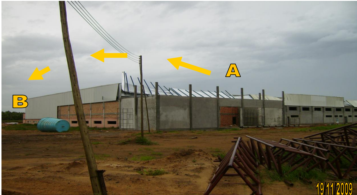
Figura 6 - A estrutura metálica voou por cima do pavilhão
