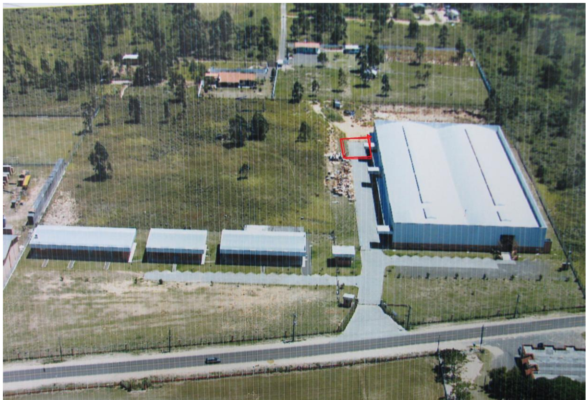
Figura 3 - Vista aérea do pavilhão industrial antes de ser ampliado, com destaque em vermelho do local do futuro deck.
