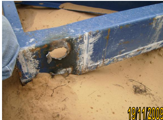
Figura 10 - Detalhe dos furos onde estava fixada.
