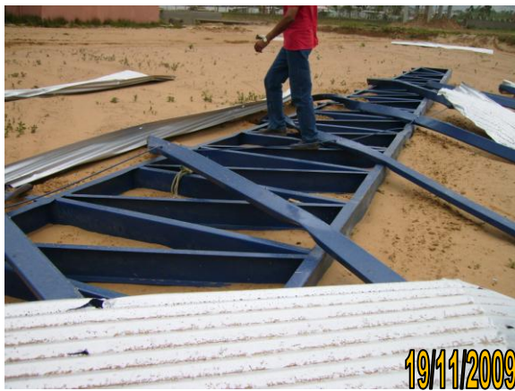
Figura 13 Estrutura metálica retorcida
