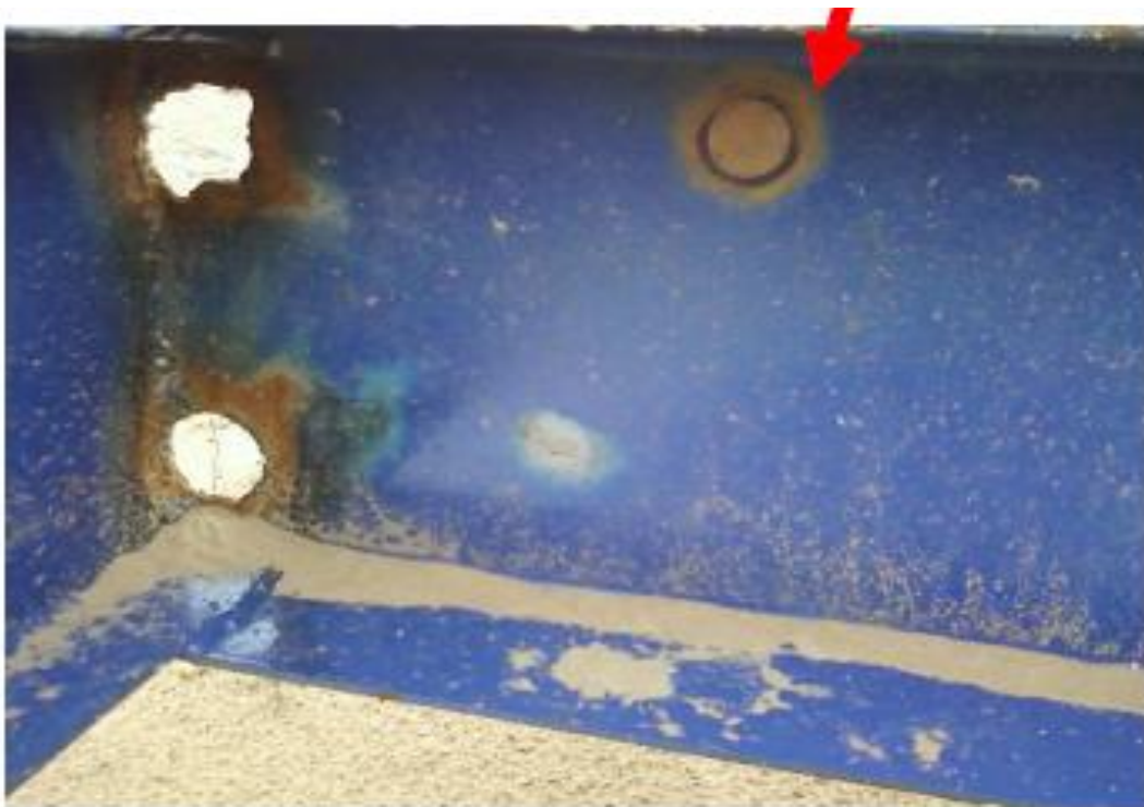
Figura 34 - Noutra estrutura marca enferrujada da porca.
