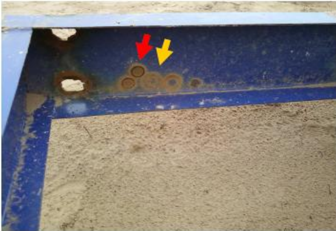
Figura 33 - Nos destroços das estruturas metálicas, observa-se que há marcas das arruelas e porcas enferrujadas ao lado dos furos. Conclui-se que as porcas e arruelas não estavam afixadas ao parafuso e juntas com a estrutura
