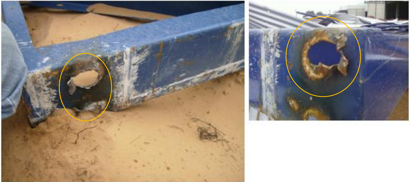
Figura 27 - Na estrutura metálica o furo está arrombado.
