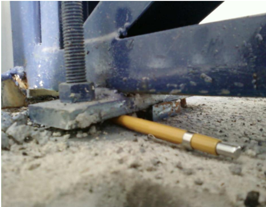
Figura 40 - Outro ponto em balanço
