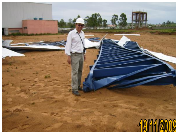
Figura 14 - Estrutura metálica retorcida
