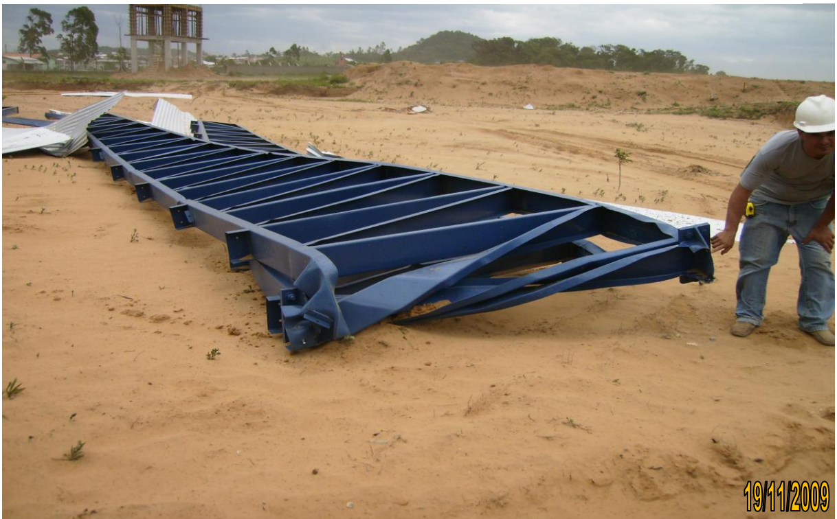
Figura 9 - A estrutura metálica ficou retorcida
