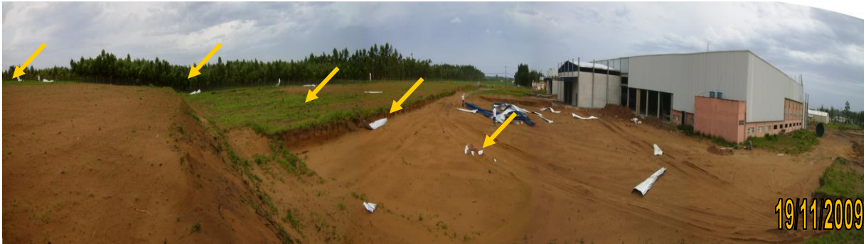
Figura 8 - Demais pedaços de telhas voaram mais longe e chegaram a mais de 200 metros
