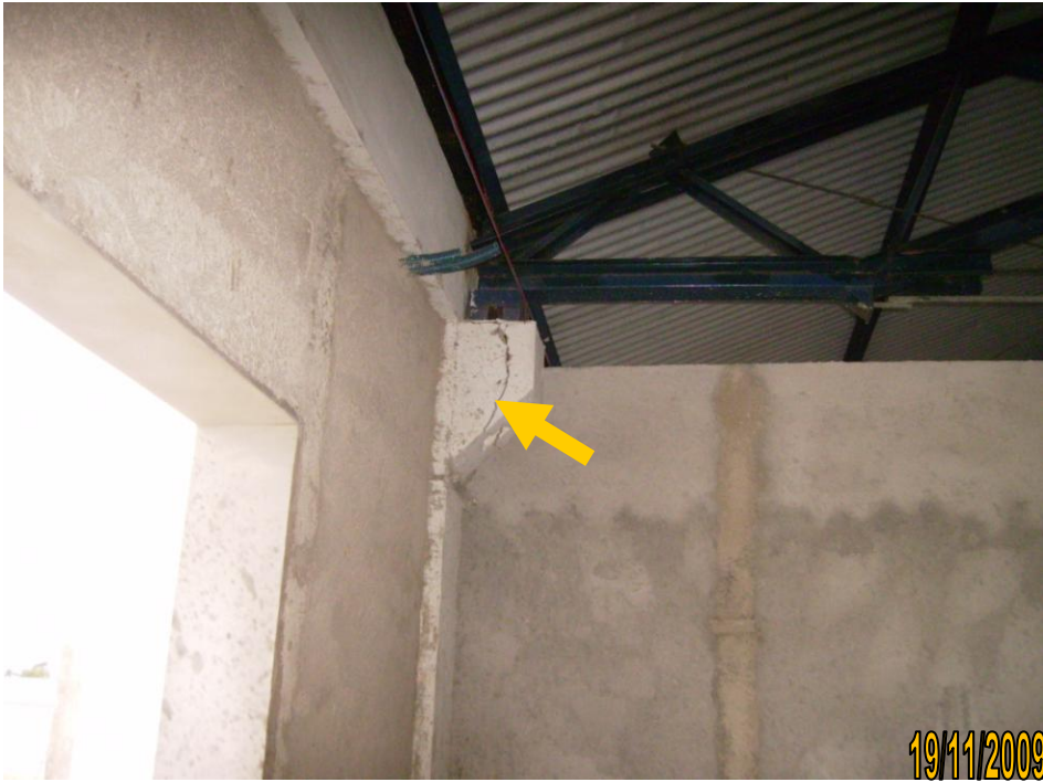
Figura 21: No detalhe o console trincado
