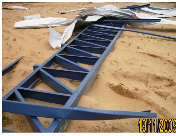
Figura 12 Estrutura metálica retorcida
