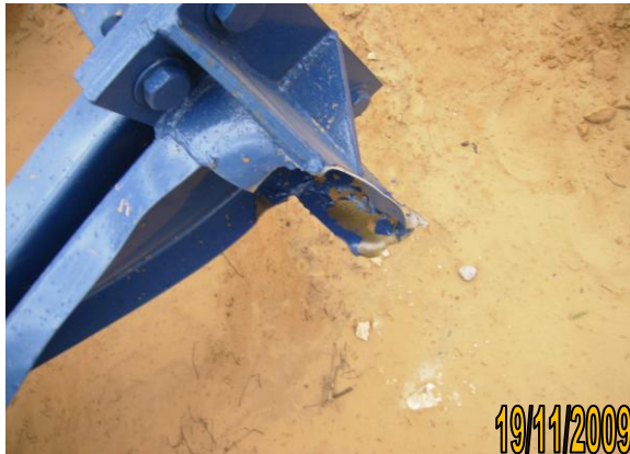
Figura 11 - Estrutura metálica retorcida e rasgada
