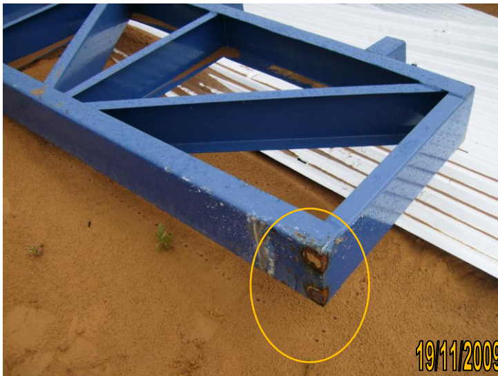
Figura 16 - Os furos de fixação com os pilares estavam arrombados
