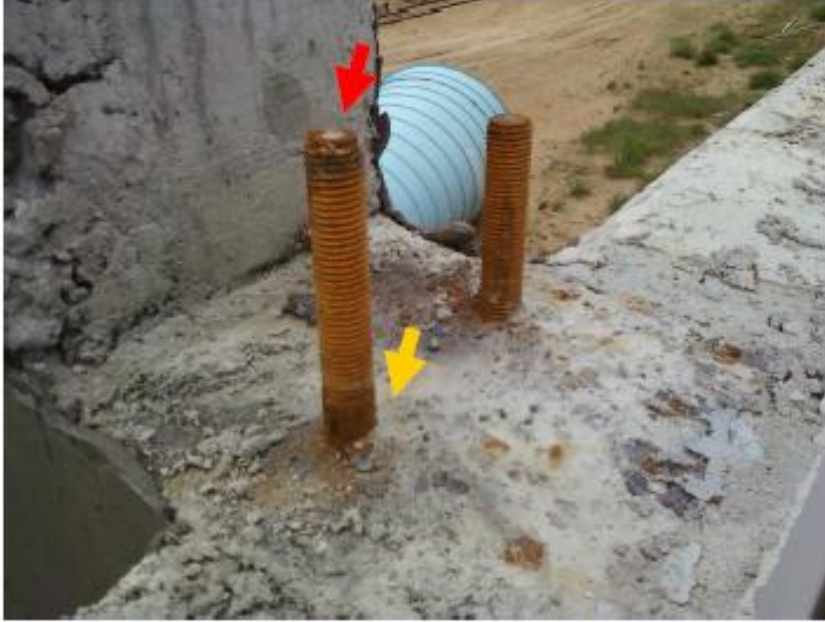
Figura 29 - Os parafusos no topo do pilar estão sem porca ou arruela e não tem indícios de estar espanado.
