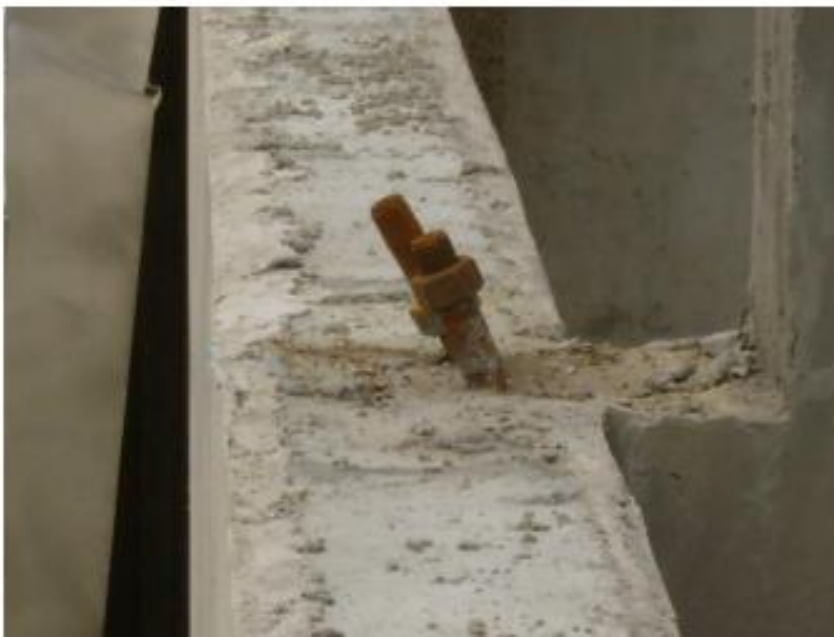
Figura 26 - Observa-se que há parafusos com porca sem arruela, sem estar espanada. Observando melhor, nota-se que as porcas estão longe da base
