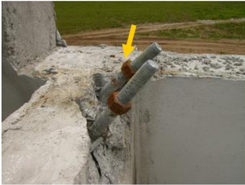
Figura 25 - Parafuso de ancoragem, quase rompido na base. Ao lado o croqui do local da foto.
