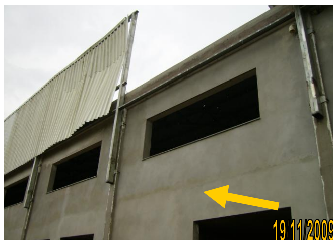
Figura 20 - Danos diversos na estrutura lateral, já mostrando que a estrutura pré-moldada era frágil para os ventos da região. Alguns painéis não resistiram e foram arrancados.
