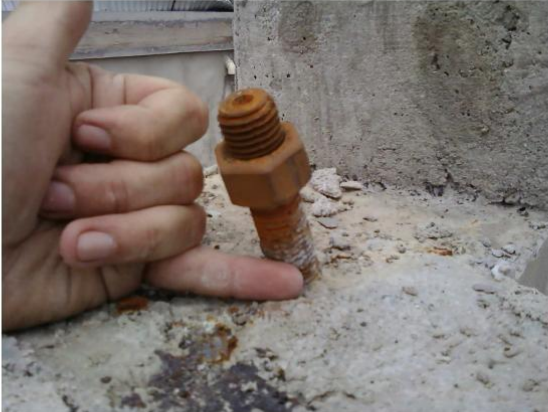
Figura 31 - Parafuso com porca muito afastada da base e está sem arruela
