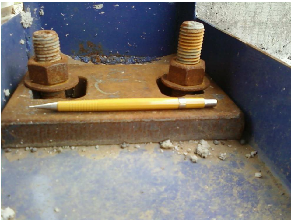
Figura 39 - Outro ponto mal afixado e sem a pintura de proteção.
