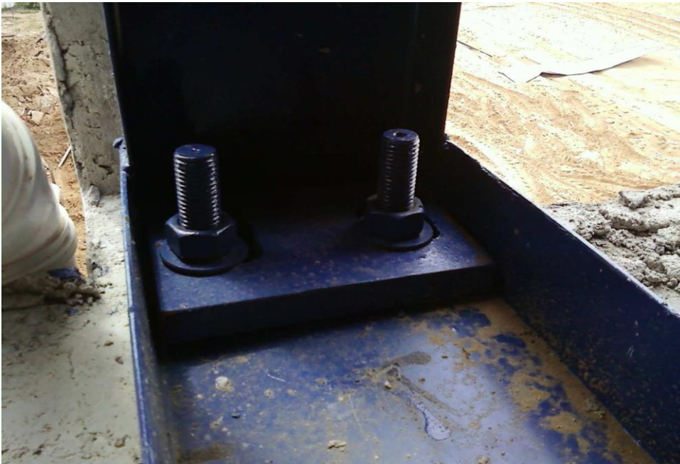
Figura 36 - Estrutura metálica afixada, com parafusos, porcas e arruelas. Se não fosse por uma observação mais detalhada deixaria de notar que a base não está de acordo, vejam as fotos seguintes.
