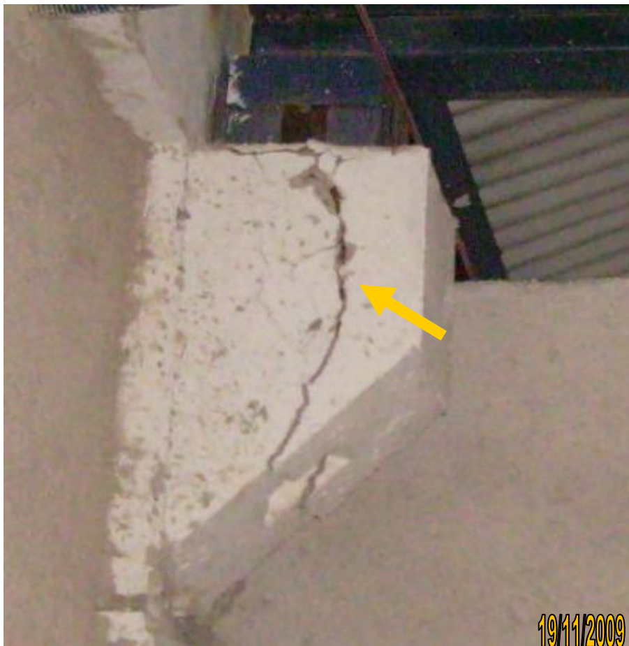
Figura 22 - Internamente, no pilar de concreto pré-moldado, nas cabeças de apoio, houve rompimento. Acontecendo em outros consoles também.
