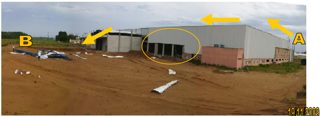
Figura 7 – A estrutura metálica voou do ponto A para o ponto B, percorrendo uma distância de 80 metros. Em destaque, aberturas que propiciam o sotavento
