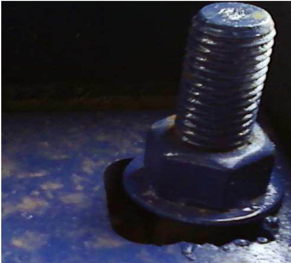
Figura 38 - No detalhe a fixação da estrutura está levemente afixada.
