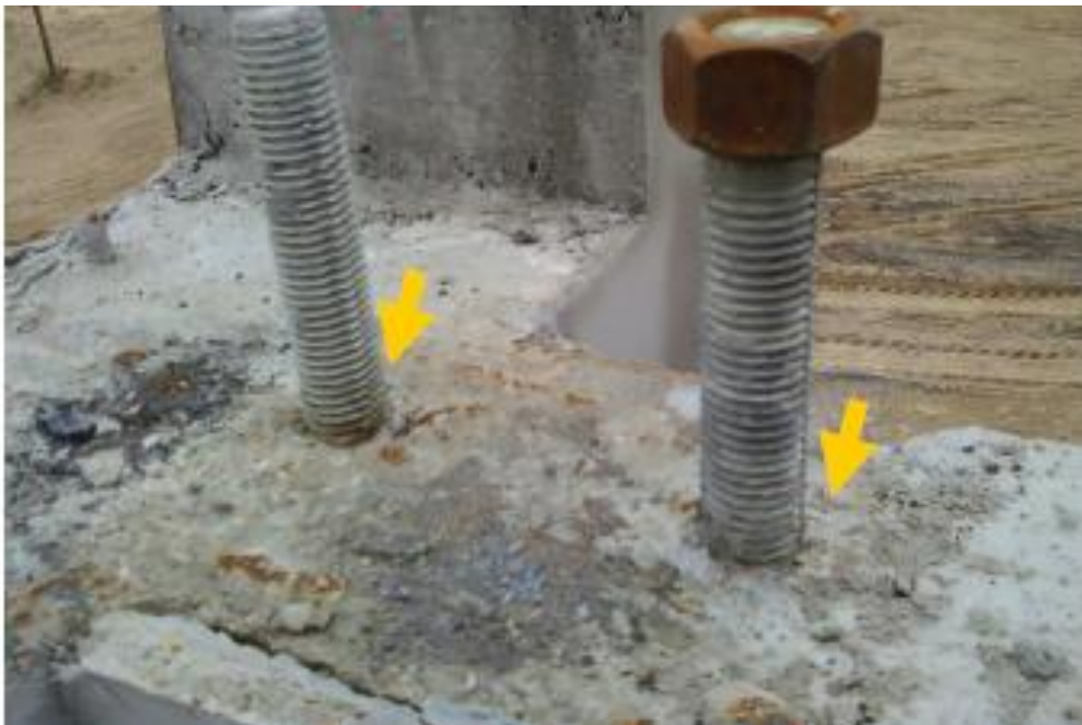
Figura 28 - Os parafusos não estão com a rosca espanada e a porca está na ponta do parafuso no outro sem a porca. Não há arruela. Esta observação conclui-se que não estavam bem afixadas à base.
