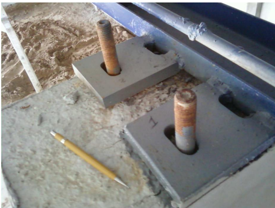
Figura 41 – Parafusos e estrutura metálica sem estar afixadas
