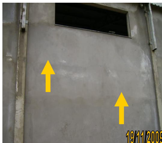
Figura 19 - Os painéis que resistiram exerceram uma pressão nas paredes que causou rompimento da estrutura de concreto e alvenaria
