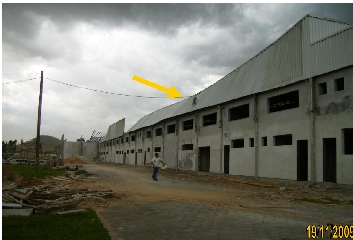
Figura 18 - Minutos após o vento forte, o beiral em painéis metálicos e pilares foram atingidos com mais intensidade. O painel do beiral tinha uma extensão de 80,20m de comprimento com altura de 3,00m, total 240 m 2
