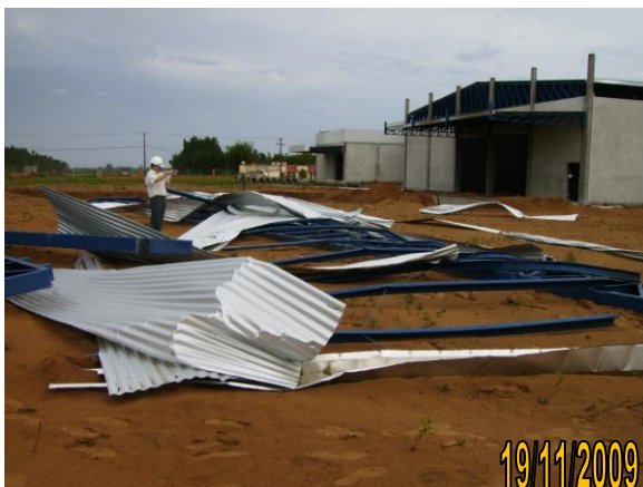
Figura 15 - Telhas e estrutura metálica retorcida
