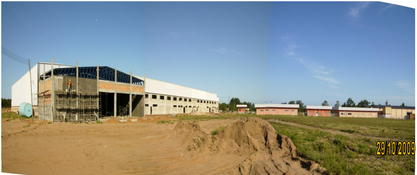
Figura 4 - O deck foi construído em pilares em concreto armado moldados in loco com cobertura em estrutura metálica e telhas aluzinco. Observa-se as aberturas para colocação dos portões, que são 3, propicia o barlavento.
