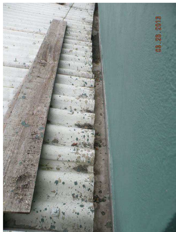
Figura 17 – Observar a inexistência da limpeza dos resíduos na cobertura com telhas de fibrocimento. Observar o desalinhamento das telhas.
