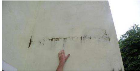
Figura 38 - Observar a trinca existente na divisa do ultimo geminado, no fundos do geminado.
