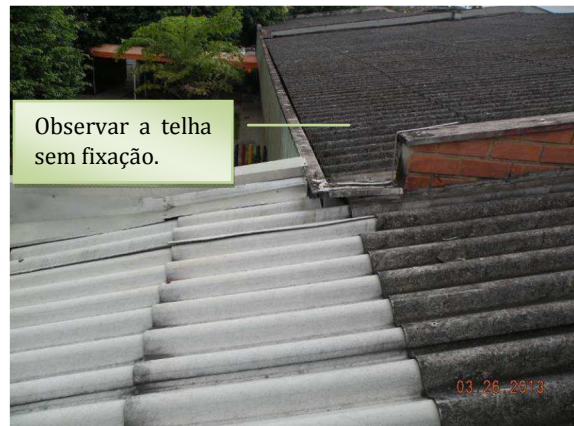
Figura 15 – Vista parcial do telhado na data da perícia.
