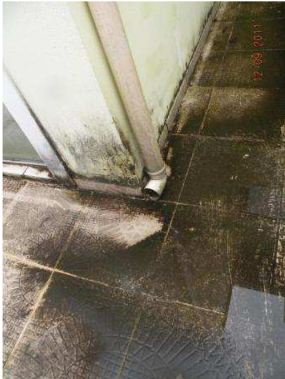
Figura 37 - Cita-se que a tubulação de águas pluviais descem no piso cerâmico nos fundos do imóvel.
