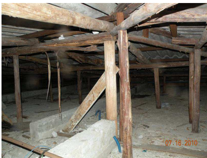
Figura 1 - Fotografia executada onde é possível observar a estrutura da cobertura do imóvel. Observar a existência de madeira de caixaria, que serve como apoio para as escoras.
