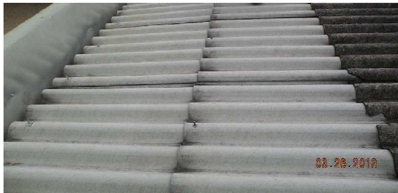
Figura 14 – Vista parcial do telhado, observar a existência de telhas de fibrocimento quebradas.
