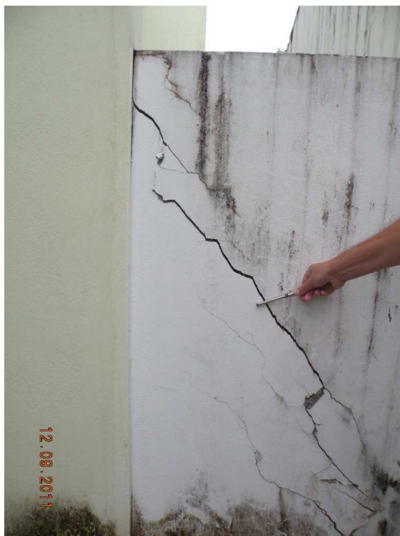
Figura 36 - Efetuar o reforço na fundação, demolir e refazer a alvenaria entre o muro e a casa dos fundos será necessário.
