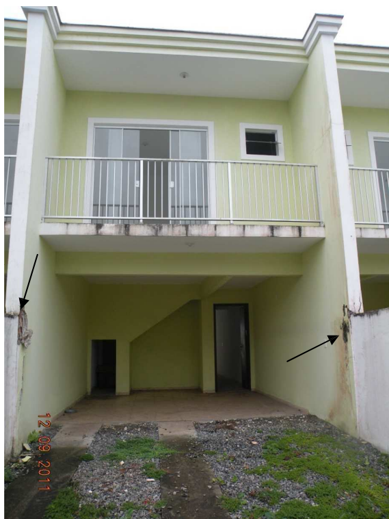
Figura 35 - Vista frontal do geminado que se localiza no meio. Observar as fissuras existentes entre a casa e o muro; e as fissuras existentes entre as paredes divisórias.
