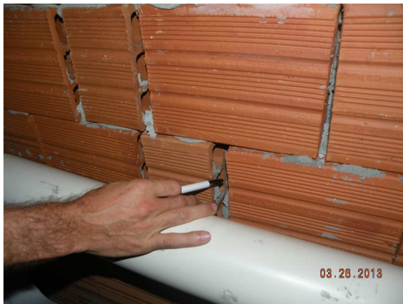
Figura 33 – Observar os espaçamentos entre os tijolos, assim como a falta de argamassa.
