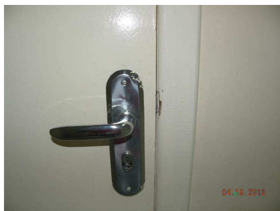
Figura 27 – Estado das ferragens das portas.
