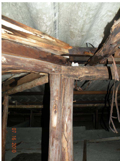
Figura 2 - Observar a disposição das madeiras, sem nenhum critério técnico; a misturas de madeiras: escoras de eucalipto, madeiras de caixaria e itaúba; a argamassa ainda na escora que foi reutilizada; e a presença de infiltração de águas de chuva na madeira.
