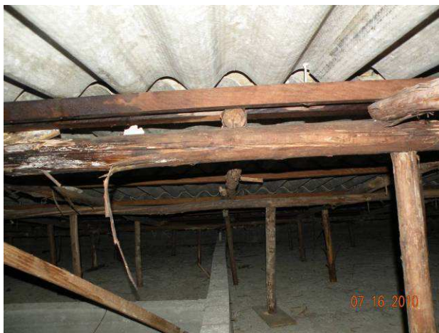
Figura 4 - Observar a inexistência de dimensões comerciais de madeira, e o reaproveitamento de madeiras destinadas a uso temporário como escoramento e de caixaria.
