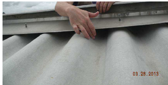
Figura 21 – Na cobertura da torre da caixa d'água observar que o rufo entre a alvenaria e a telha de fibrocimento não acompanha o formato da telha de fibrocimento como a crista e a cava. Este espaço ou abertura facilita a penetração de águas de chuva.
