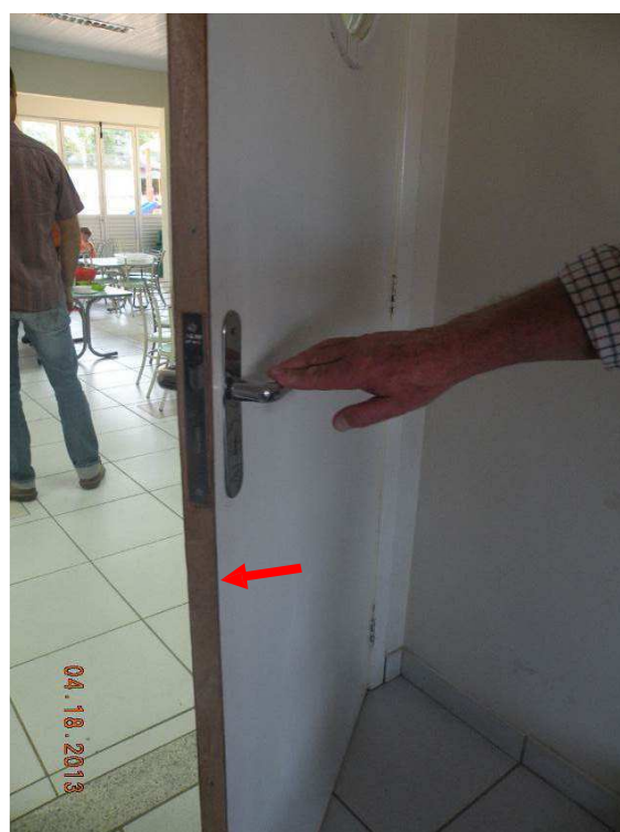
Figura 28 – Observar a falta de acabamento na porta.
