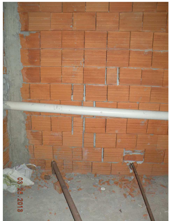
Figura 34 – Vista geral de uma das paredes, no local onde fica a caixa d'água.
