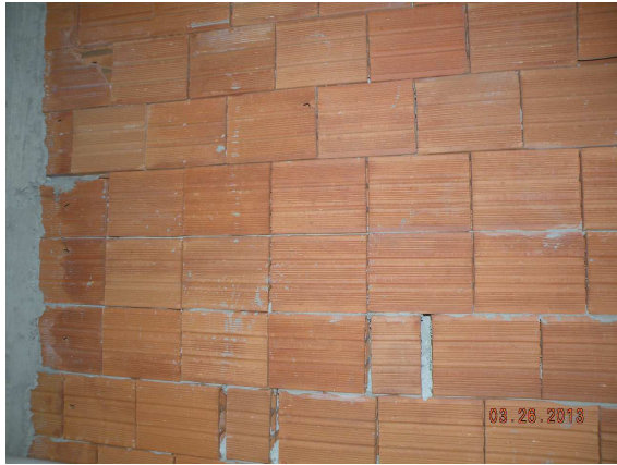
Figura 31 – Constata-se que não há travamento entre os tijolos.
