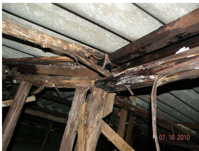
Figura 3 - Observar o apodrecimento da madeira. Referida desintegração avançada da madeira é devido à infiltração de água de chuva e o tipo de madeira inapropriado para este fim. Observar também a disposição da madeira, sem nenhum critério técnico.
