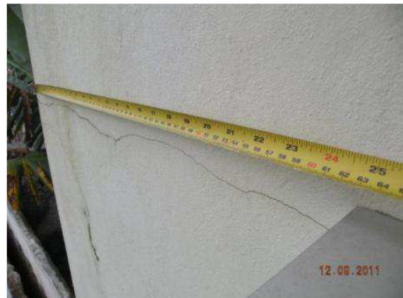
Figura 40 - A parede de divisa entre os geminados e após o término da construção deve ter 1,50 metros pela legislação municipal, e conforme projeto; e no local está com 62,80 cm.
