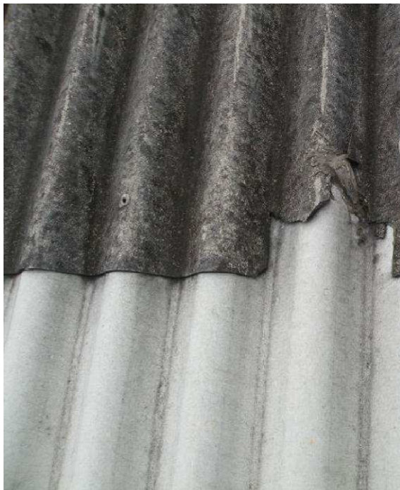
Figura 16 – Observar o estado da telha de fibrocimento mais antiga e a telha de fibrocimento nova.
