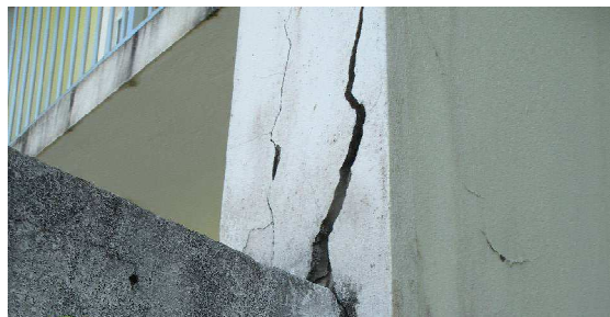
Figura 41 - Observar as trincas entre o muro e a parede de divisa do 1º e o 2º geminado.
