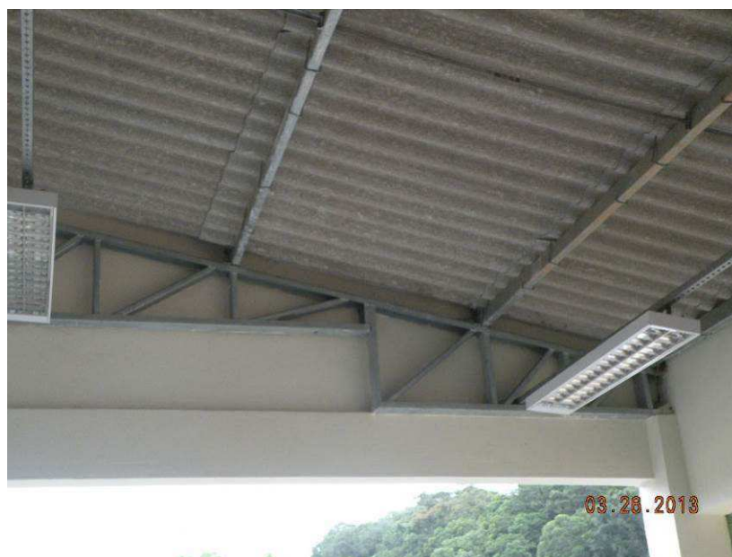
Figura 10 – Vista parcial da cobertura. Recomenda-se que o calculista estrutural e de execução efetue uma revisão nas estruturas metálicas da cobertura.
