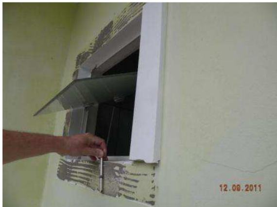
Figura 39- Observar o descolamento das molduras existentes.
