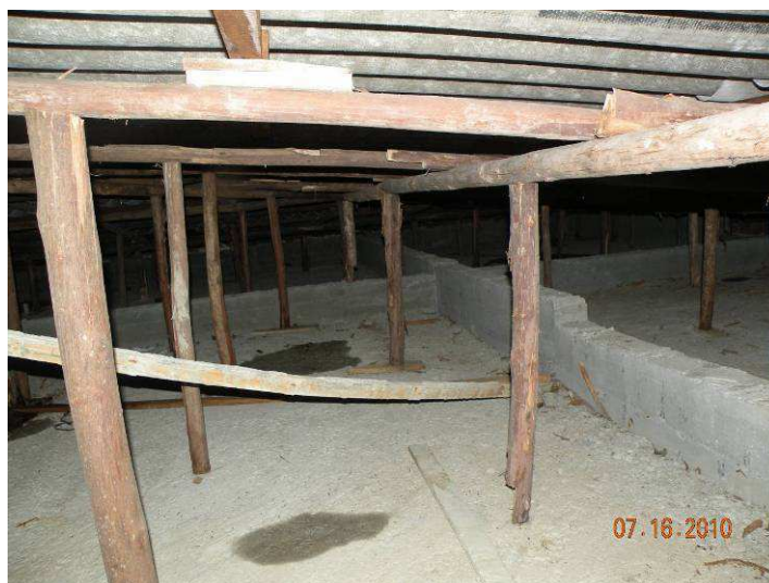
Figura 5 - Observar as madeiras utilizadas, a péssima execução do telhado, com a existência de pedaços pequenos de madeira que servem como apoio na estrutura da cobertura; assim como a presença de água na laje devido a infiltração existente
