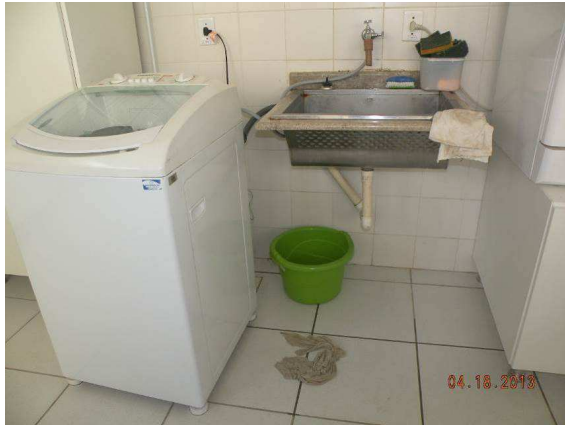
Figura 23 – Constatou-se que não há tubulação para a saída da água da máquina de lavar roupa, na área de serviço.
