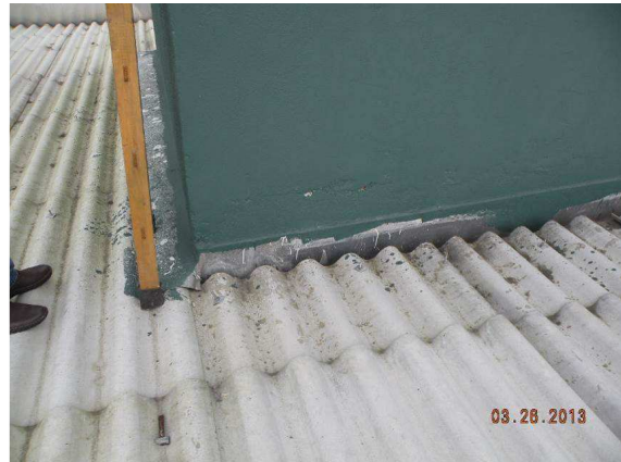
Figura 19 – Cita-se o pouco espaço para o escoamento das águas da chuva.
