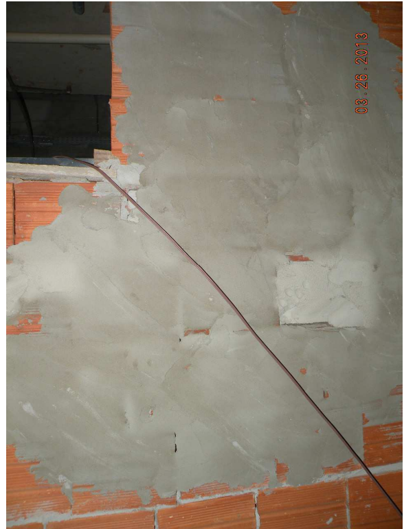
Figura 32 – Tubulação elétrica fora do eletroduto e sem estar embutida.
