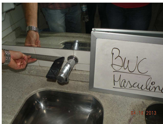
Figura 30 – Observar a má colocação das torneiras nos banheiros.
