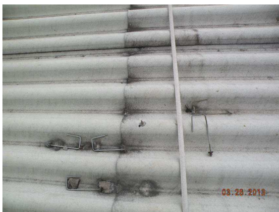
Figura 12 – Vista parcial da cobertura. Observar os ganchos fixadores das telhas de fibrocimento não utilizados e deixados na cobertura.
