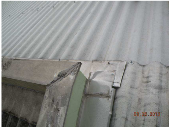
Figura 18 – Observar a existência de um espaço entre as telhas e o rufo.
