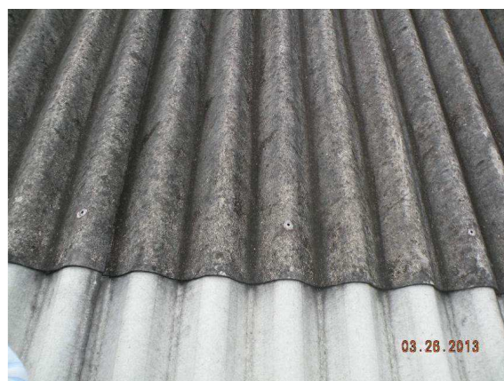
Figura 13 – Observar a inexistência de parafusos para fixação das telhas.
