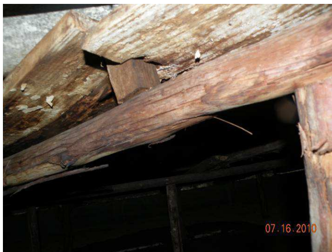
Figura 6 - Inexistência de critérios técnicos na execução da estrutura de madeira da cobertura em questão.
