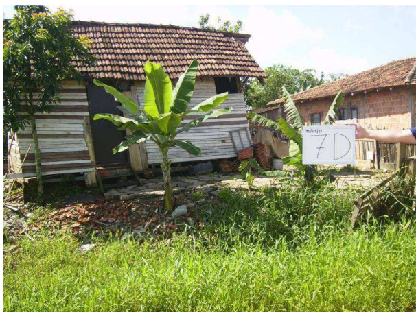
Imagem n.º 12. Vista parcial de uma casa próximo a Rua Porto Seguro (Ponto n.º 7).
