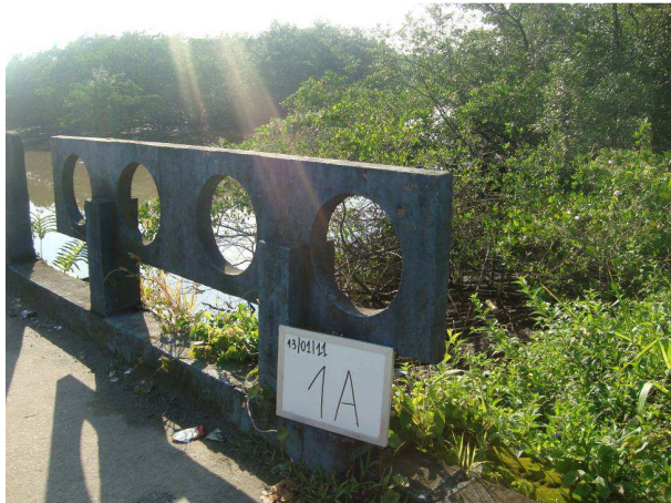
Imagem n.º46 – Vista da ponte localizada na rua Guanabara sentido sul.
