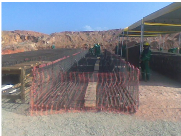
Img. 11 – Pré-armação
