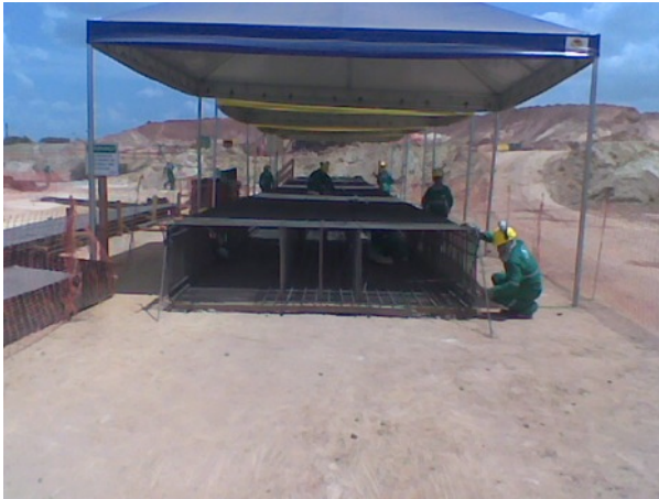
Img. 12 – Término da armação
