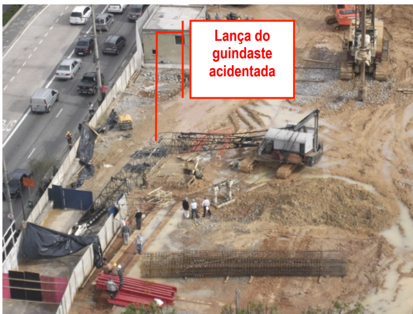
Img. 21 Canteiro de obras após o acidente, com a lança do guindaste danificada
