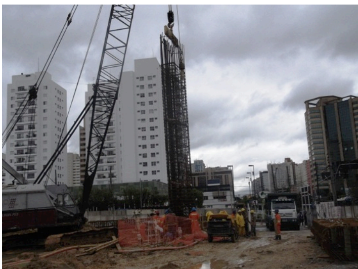
Img. 26 – Execução da descida da armação da lamela da parede diafragma, antes do acidente
