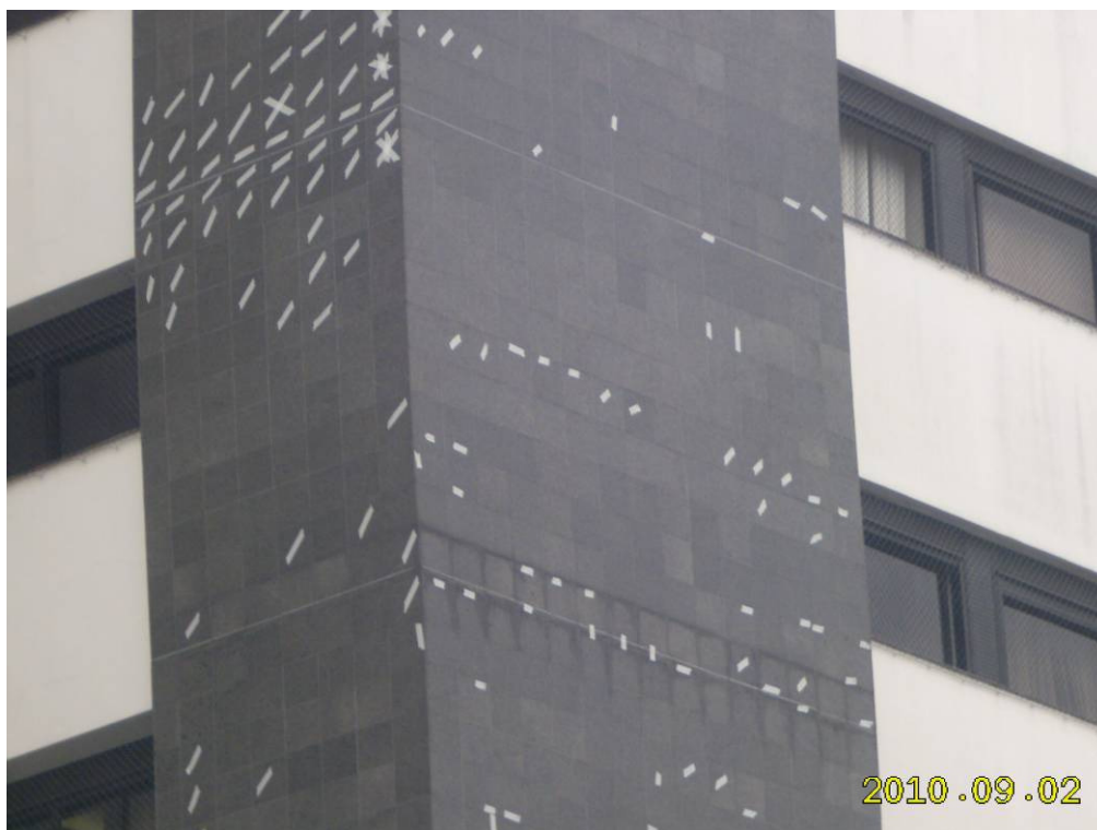
Figura 22: MAPEAMENTO. Vista das FACES G/ H.
