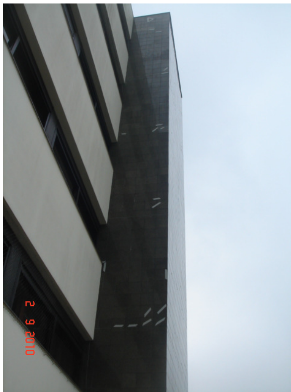
Figura 18: MAPEAMENTO. Vista geral da FACE D.
