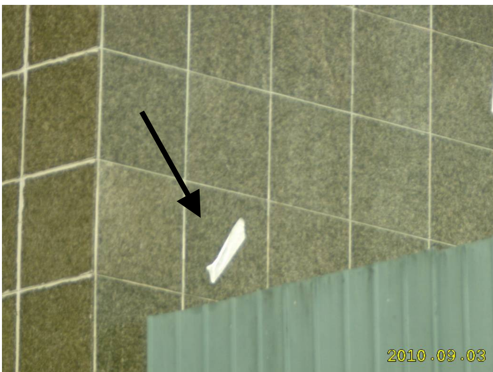
Figura 15: MAPEAMENTO. No detalhe, placa marcada por apresentar som cavo.
