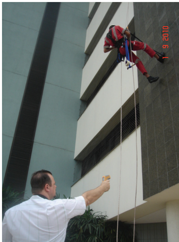
Figura 13: MAPEAMENTO. No detalhe, medição da temperatura do substrato, por uso de termômetro laser.
