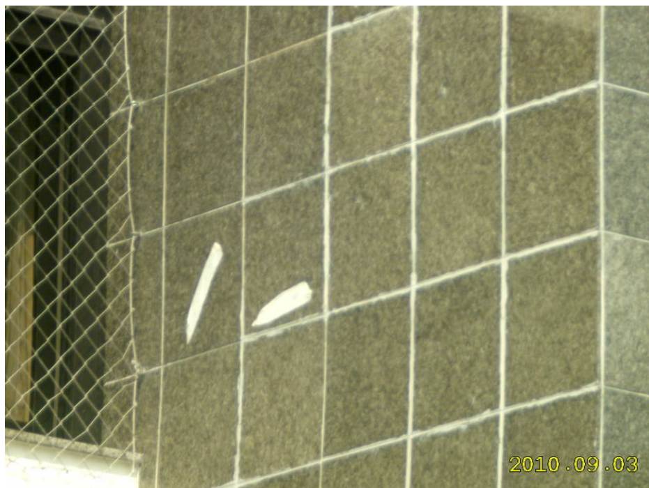
Figura 44: MAPEAMENTO. No detalhe, evidências de intervenção de manutenção no rejunte.
