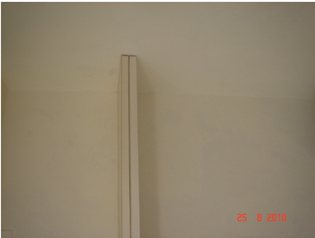
Figura 09: QUARTO 911/ LEITO 01 - No detalhe trinca e evidências de umidade na parede.
