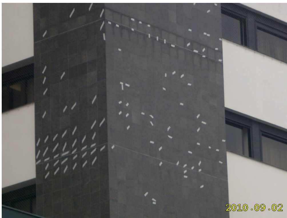
Figura 23: MAPEAMENTO. Vista das FACES G/ H.
