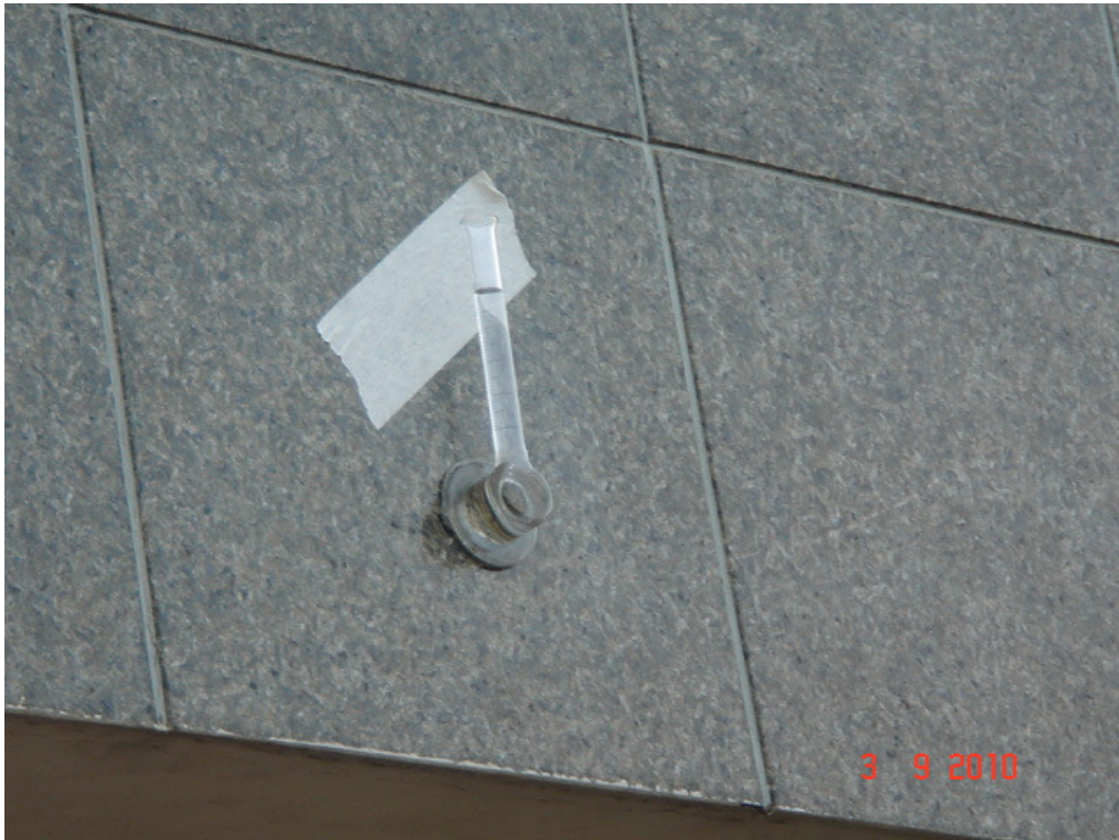
Figura 36: TESTE DE PERMEABILIDADE A BAIXA PRESSÃO. No detalhe, realização em placa com som cavo.
