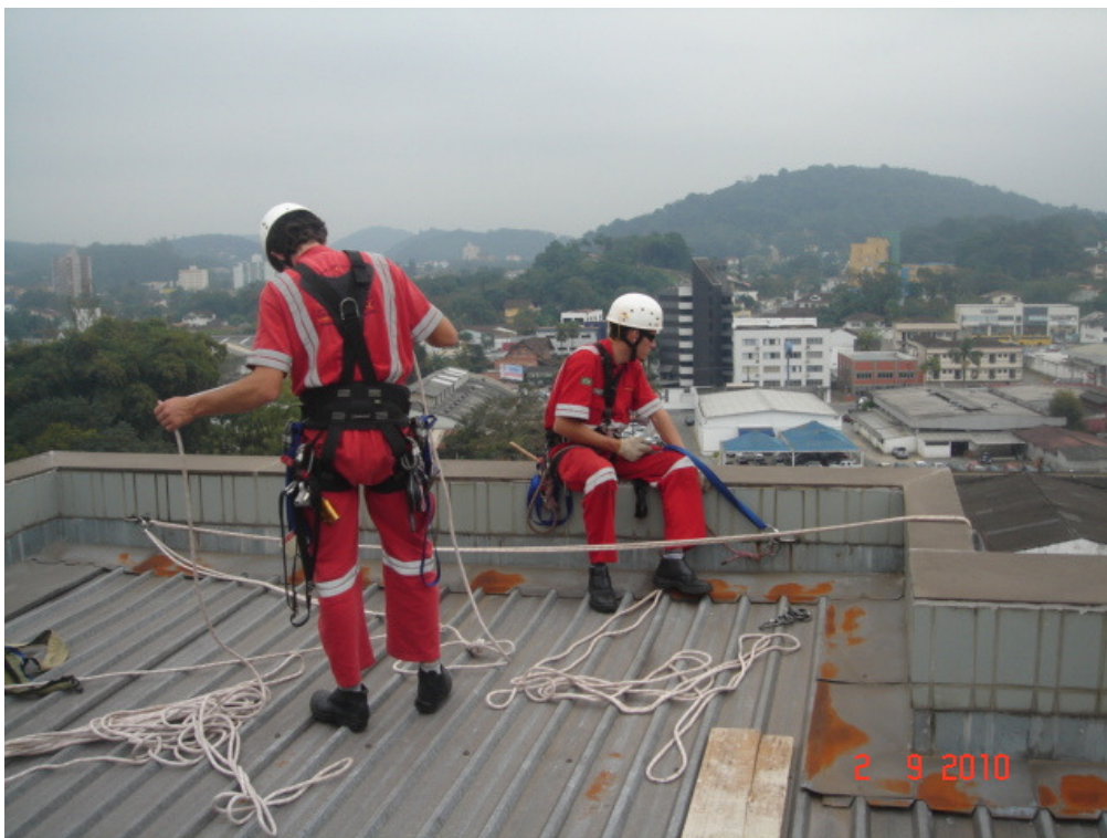
Figura 10: MAPEAMENTO. Etapa de preparação para início dos trabalhos.
