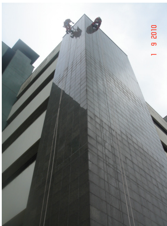
Figura 40: MAPEAMENTO. Observar o manchamento ocasionado pelo selante utilizado nas juntas de dilatação horizontais, ao longo de ELEMENTO ABC.
