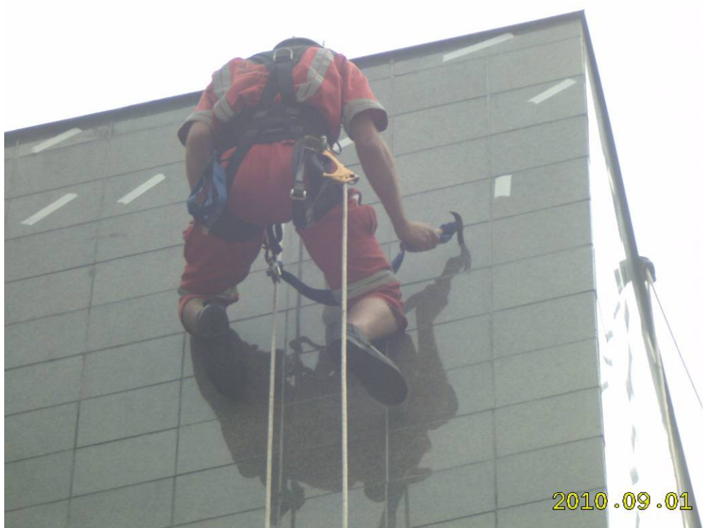
Figura 12: MAPEAMENTO. No detalhe, teste de percussão sendo realizado.
