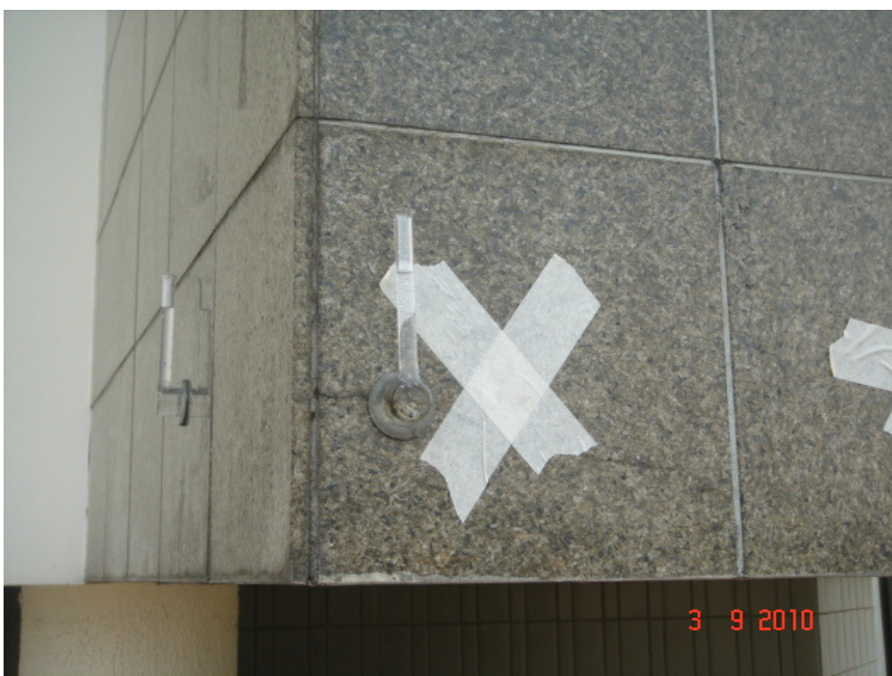
Figura 35: TESTE DE PERMEABILIDADE A BAIXA PRESSÃO. No detalhe, realização em placa trincada.
