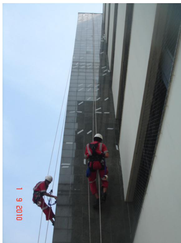
Figura 17: MAPEAMENTO. Vista geral da FACE C.
