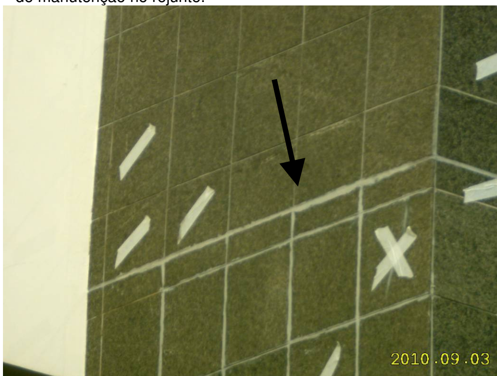
Figura 45: MAPEAMENTO. No detalhe, evidências de intervenção de manutenção na junta de dilatação horizontal.
