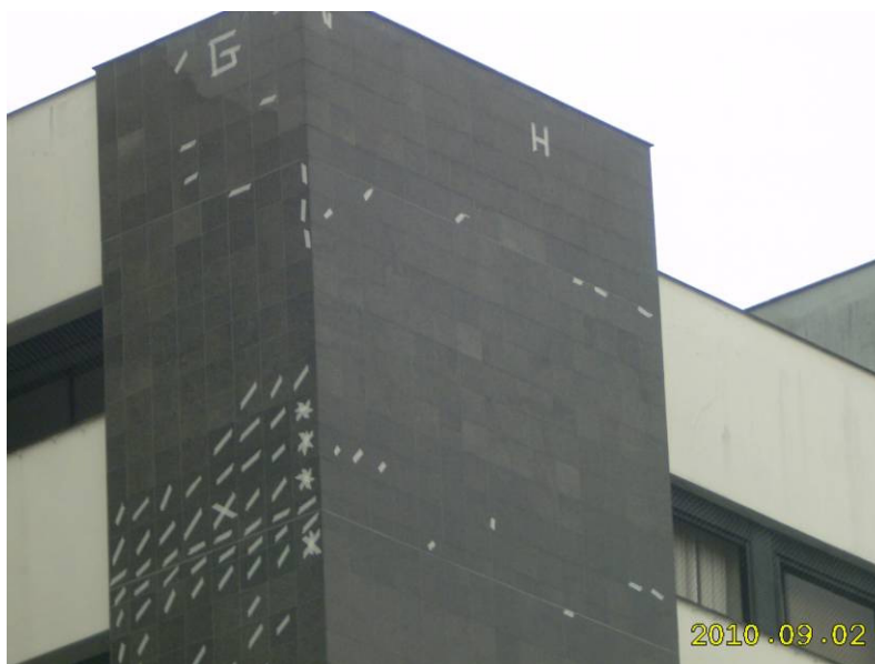
Figura 21: MAPEAMENTO. No detalhe com marcação em asterisco (*), placas embricadas e em processo de deslocamento espontâneo, FACE G.
