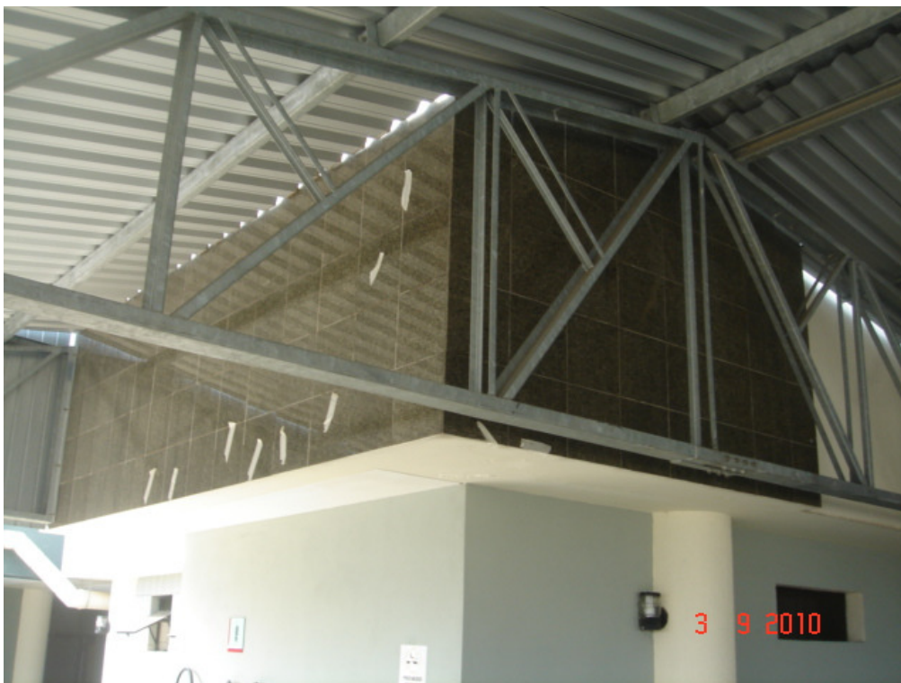
Figura 28: MAPEAMENTO. No detalhe extremidades das FACES K/ L.
