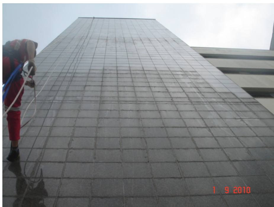
Figura 39: MAPEAMENTO. Vista geral da FACE B, evidenciando o manchamento proveniente do mástique usado nas juntas de dilatação horizontais.
