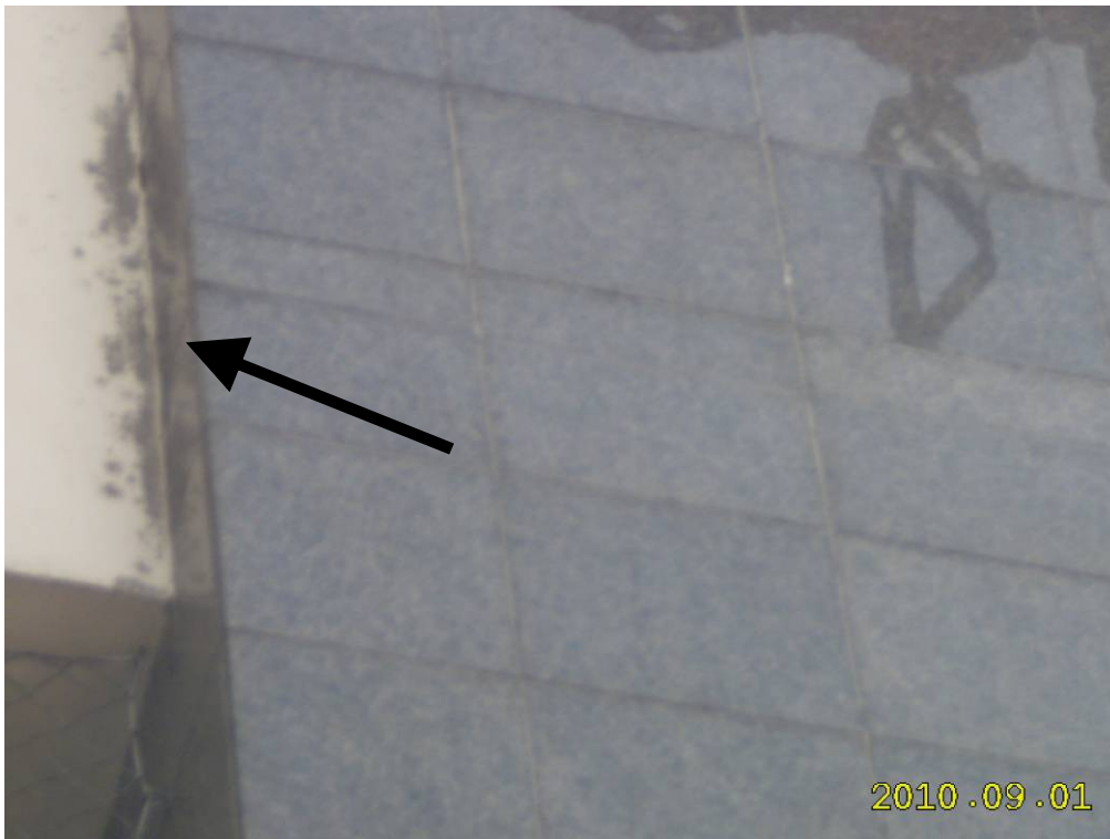
Figura 46: MAPEAMENTO. No detalhe presença de manchas de umidade no encontro das placas de granito com a alvenaria.
