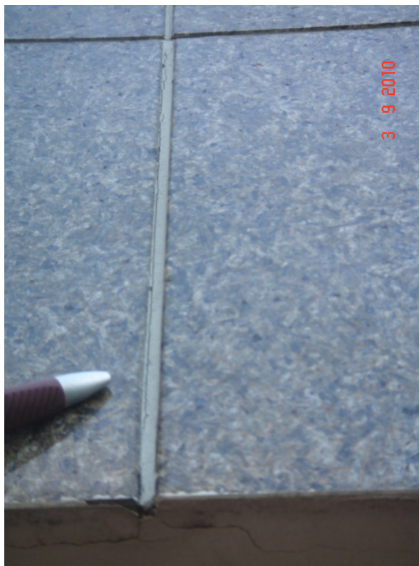
Figura 31: MAPEAMENTO. No detalhe, observar a ocorrência de rejunte trincado.
