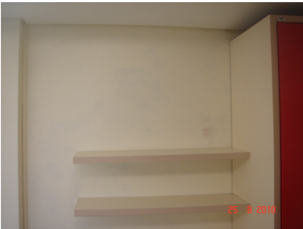
Figura 07: QUARTO 901/ LEITO 03 - Parede com umidade interna intensa e generalizada.
