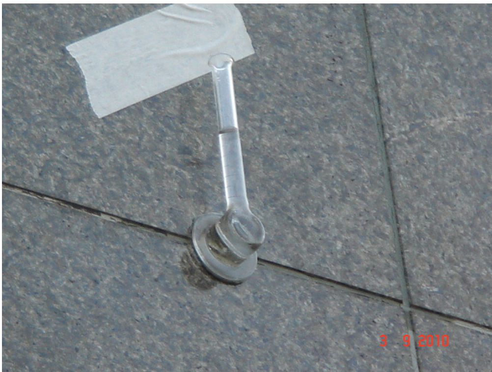
Figura 34: TESTE DE PERMEABILIDADE A BAIXA PRESSÃO. No detalhe, realização na região do rejunte.
