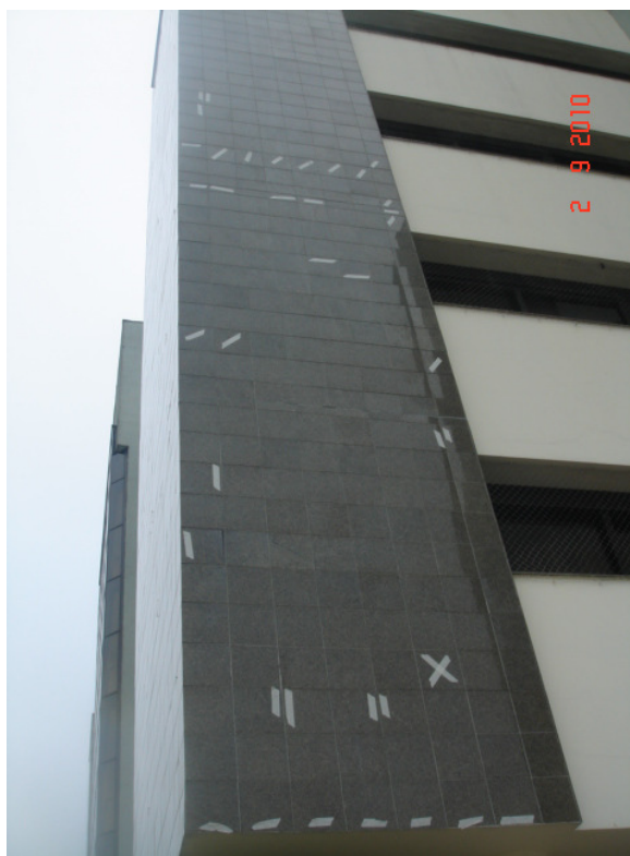
Figura 20: MAPEAMENTO. Vista geral da FACE F.
