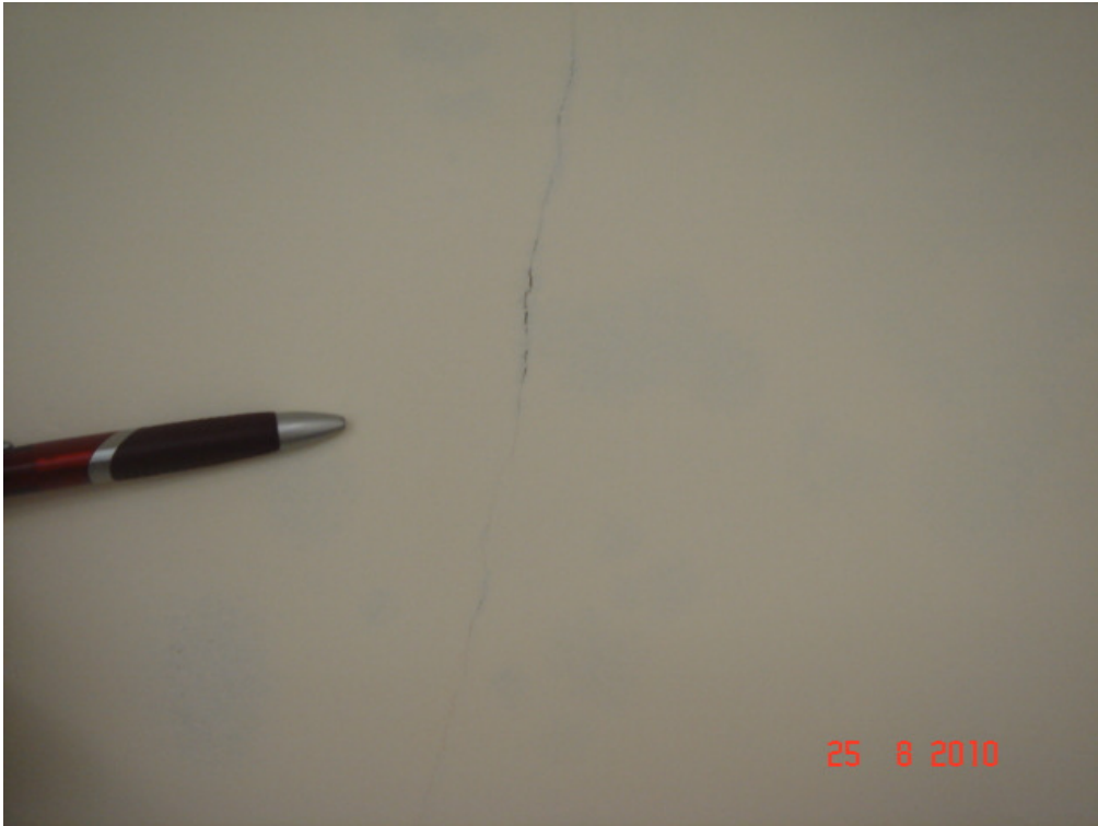
Figura 08: QUARTO 911/ LEITO 01 - No detalhe trinca e evidências de umidade na parede.
