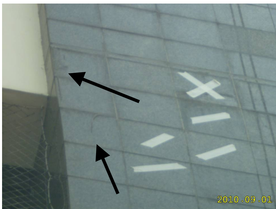
Figura 41: MAPEAMENTO. Observar o manchamento ocasionado pelo selante utilizado nas juntas de dilatação horizontais, ao longo de ELEMENTO ABC. MAPEAMENTO. No detalhe, desprendimento de reparos em rejunte.
