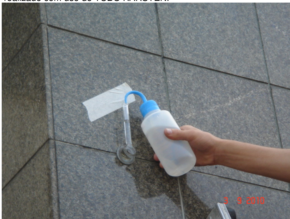
Figura 33: TESTE DE PERMEABILIDADE A BAIXA PRESSÃO. No detalhe, realização na região do rejunte.
