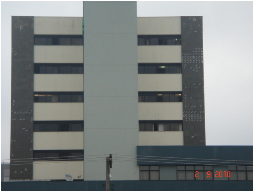
Figura 02: Vista geral do Centro Hospitalar X - ELEVÇÃO LATERAL DIREITA.
