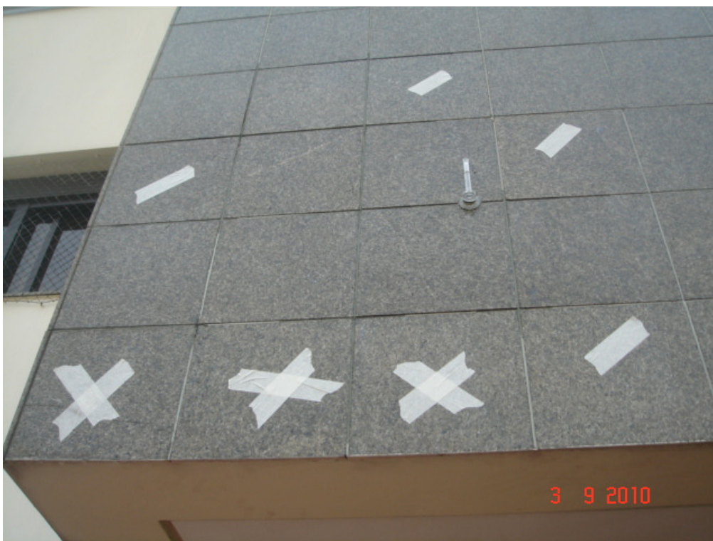
Figura 38: MAPEAMENTO. No detalhe, ocorrência de placas trincadas na extremidade da FACE E.
