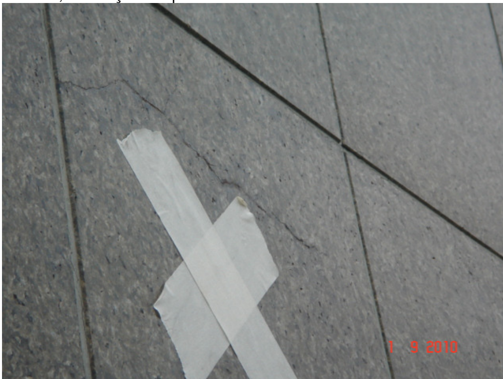
Figura 37: MAPEAMENTO. No detalhe, placa trincada.
