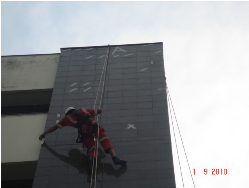
Figura 14: MAPEAMENTO. No detalhe, marcação de placas com som cavo na FACE A.
