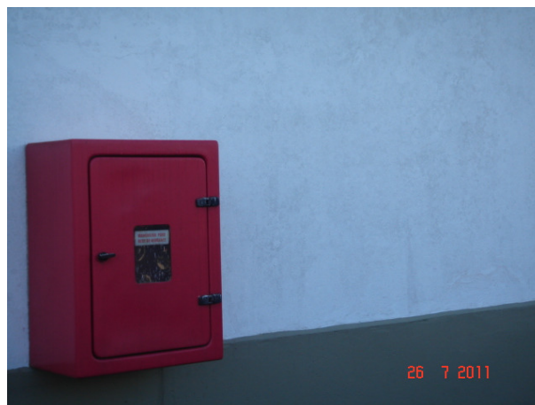
Figura 11 – Confeção/ Expedição. Face Oeste. No detalhe, manchamento generalizado presente.
