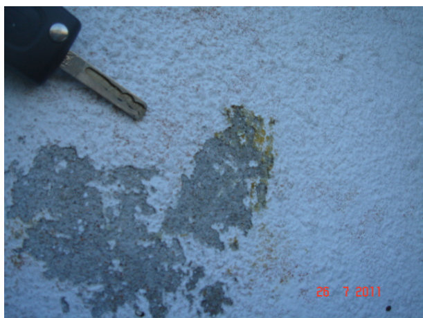
Figura 16 – Químicos. Face Oeste. No detalhe, descascamento localizado da tinta e manchamento presentes.
