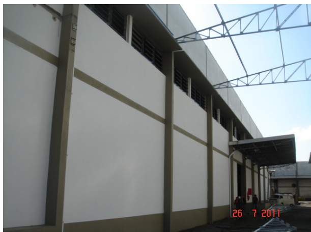
Figura 08 – Químicos. Vista geral da Face Sul. Notar ocorrência de manchamento apenas junto à platibanda.
