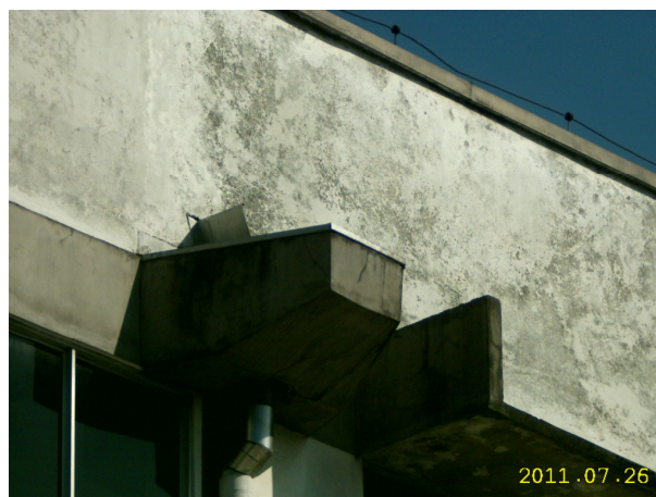
Figura 22 – Confeção/ Expedição. Face Leste. No detalhe, manchamentos presentes na parede a repintar.
