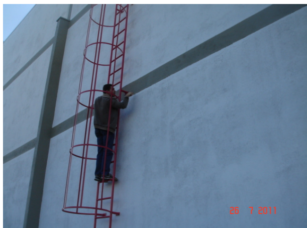
Figura 18 – Confeção/ Expedição. Face Oeste. Procedimento de abrasão sendo realizado junto à cor concreto, o qual não apresentou problema.
