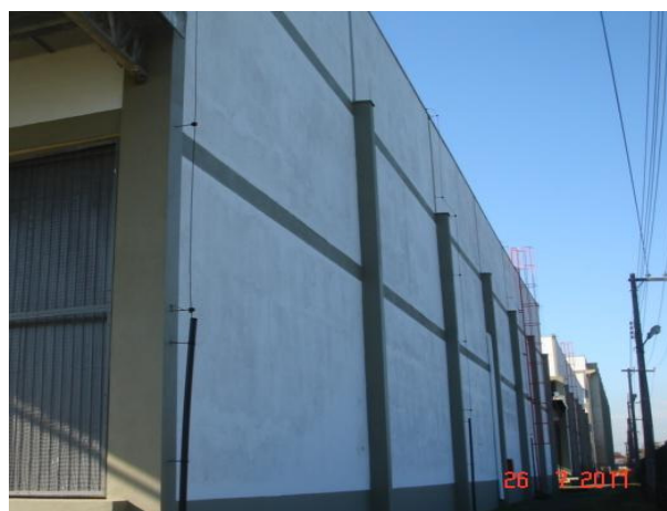
Figura 03 – Químicos. Vista geral da face Oeste, generalizadamente afetada por manchamentos.
