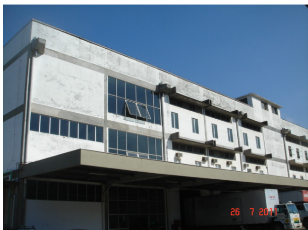
Figura 21 – Confeção/ Expedição. Vista geral da Face Leste. Parede antiga a repintar.
