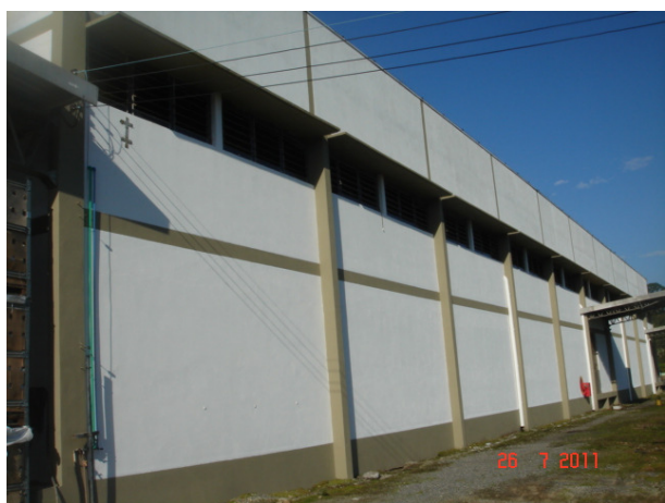
Figura 02 – Químicos. Vista geral da face Norte. Notar seu bom aspecto geral, exceto ocorrências na platibanda.
