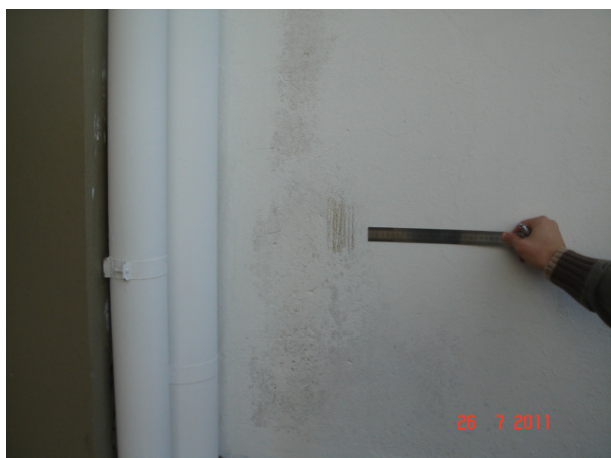
Figura 14 – Químicos. Face Sul. Observar manchamento amarelado presente quando realizada abrasão no local.
