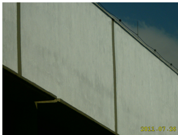
Figura 07 – Químicos. Face Leste. No detalhe, manchamento presente na platibanda.
