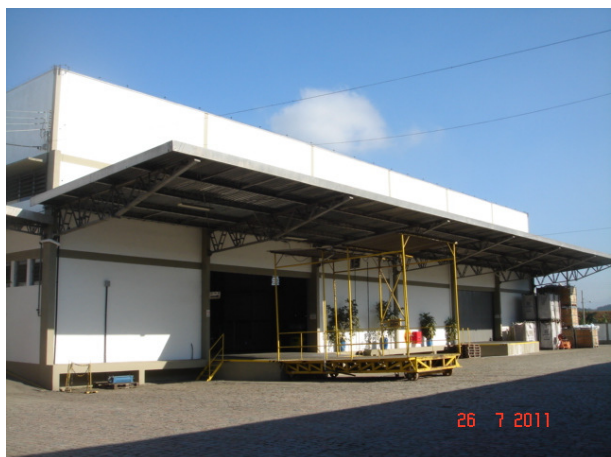
Figura 06 – Químicos. Vista geral da face Leste. Notar bom aspecto geral, com exceção da platibanda.
