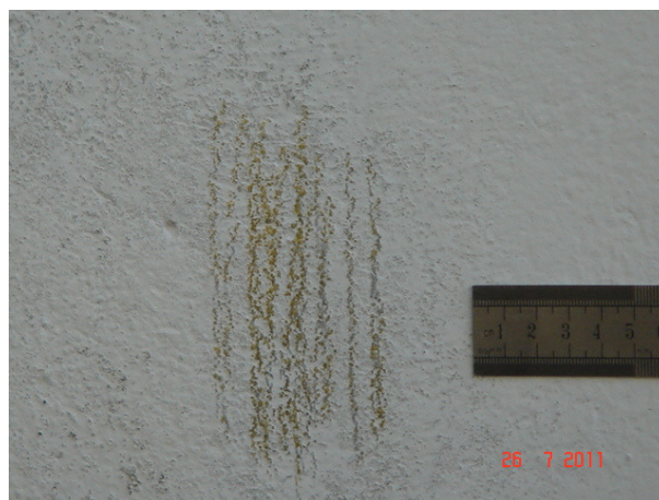
Figura 15 – Químicos. Face Sul. No detalhe, manchamento presente.
