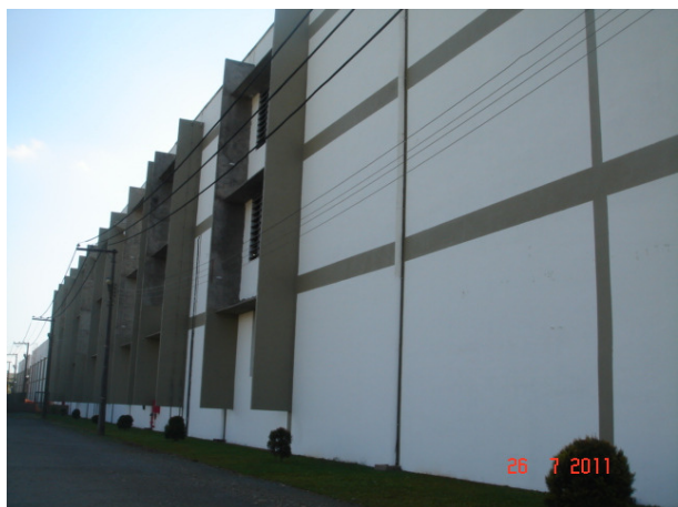
Figura 10 – Confeção/ Expedição. Face Oeste. Observar manchamento em pontos localizados e também na platibanda.
