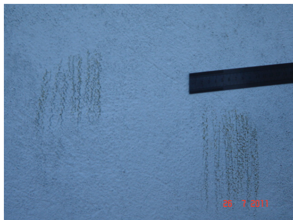
Figura 19 – Confeção/ Expedição. Face Oeste. No detalhe, manchamento amarelado presente.
