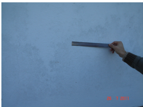
Figura 04 – Fios. Face Oeste do galpão. Observar manchamento generalizado.
