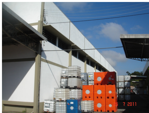
Figura 09 – Fios. Vista geral da Face Norte. Notar manchamento somente junto à platibanda.
