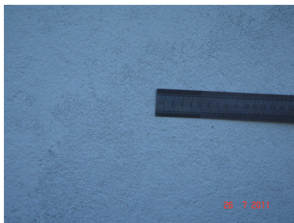
Figura 05 – Fios. Face Oeste. No detalhe, manchamento presente.
