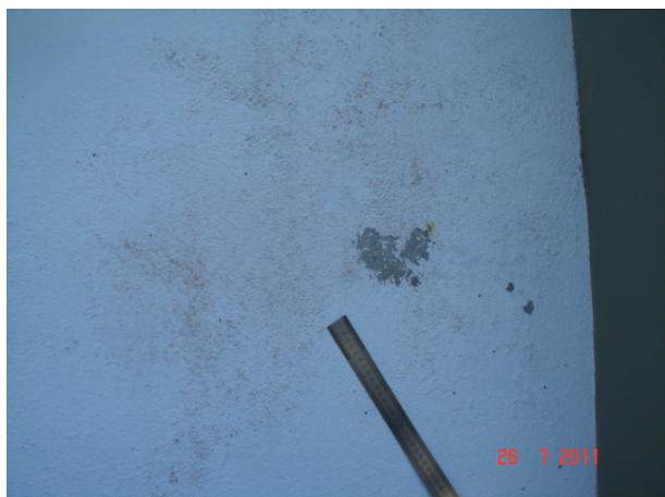
Figura 12 – Químicos. Face Oeste. Observar manchamento presente.
