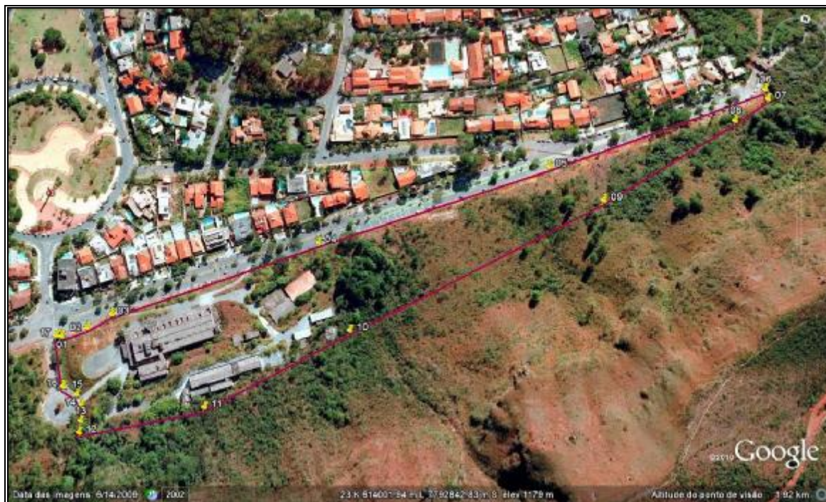
FIGURA DE Nº. 08 – VISTA DE IMAGEM AÉREA COM AS DEMARCAÇÕES DOS LIMITES DA QUADRA DE Nº. 39.
