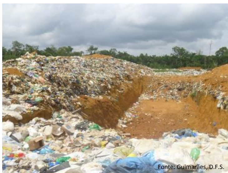
Figura 7 – Vala para aterrar os resíduos
